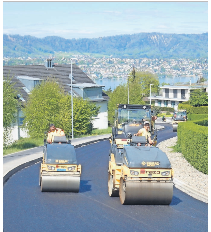
Da war es noch schönes Wetter: Belagsarbeiten auf der Forchstrasse von vergangener Woche. Wegen des Regens gab es einen Unterbruch. Foto: zvg.
