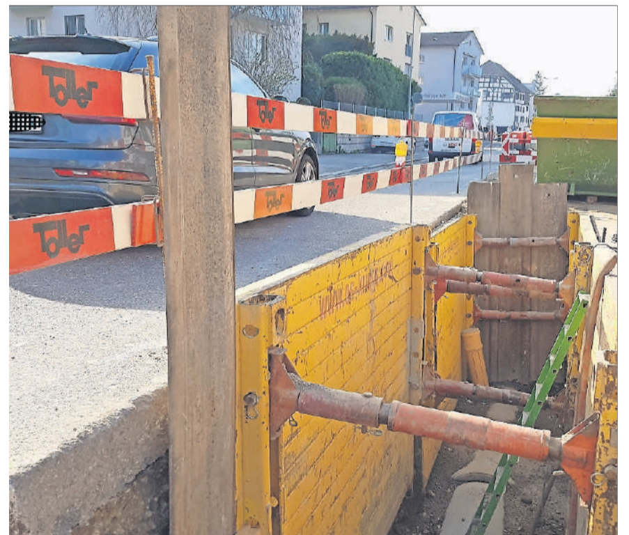
Mit der Seestrasse wird auch die Kanalisation darunter erneuert. Foto: dh.
