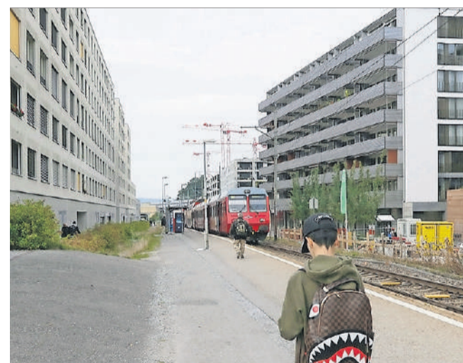
Die Genossenschaftssiedlung (l.) ist Teil von Greencity, obwohl jenseits der Bahngleise gelegen.
