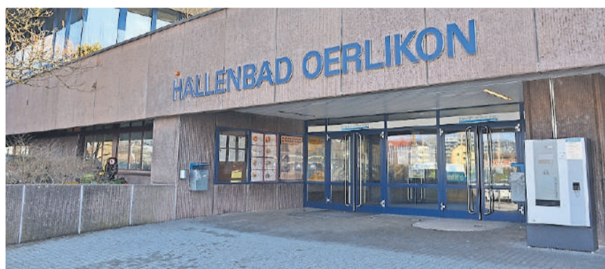
Das Hallenbad Oerlikon ist sanierungsbedürftig.
