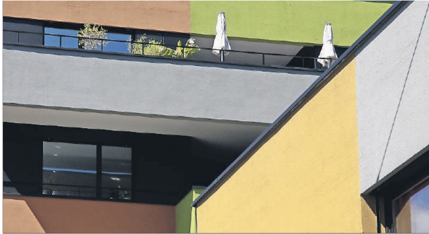
Wohnen in Baugenossenschaften, hier in Affoltern, ist beliebt. Der Stadtzürcher Dachverband wird 2019 100-jährig. Foto: mai.
