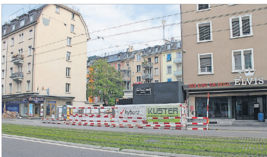
Im August wurden die Bauarbeiten wieder aufgenommen. Foto: Larissa Jurczek
