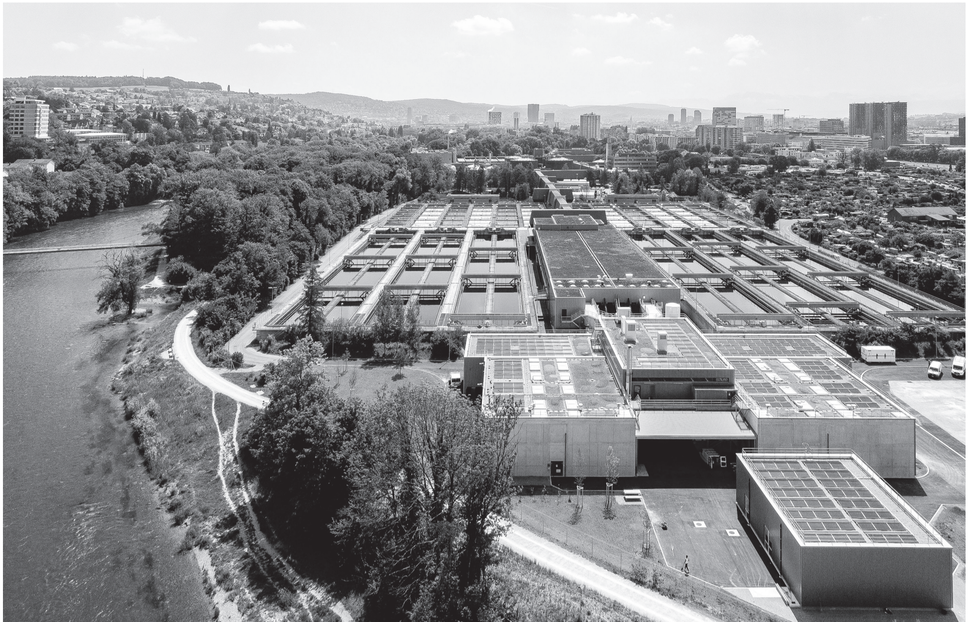
In Altstetten und Teilen von Höngg sollen Gebäude mit Energie aus gereinigtem Abwasser aus dem Klärwerk Werdhölzli klimafreundlich geheizt und gekühlt werden.
