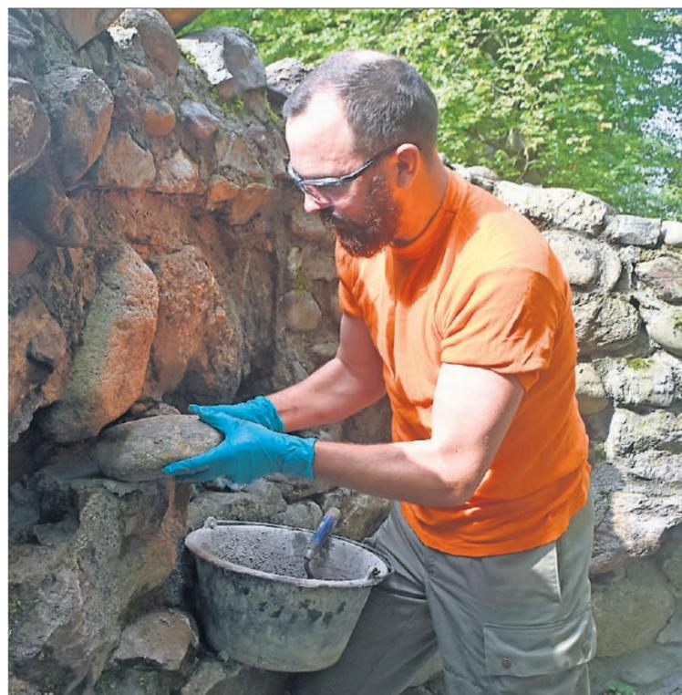
Er wird präzise in die Lücke der alten Mauer eingemörtelt.
