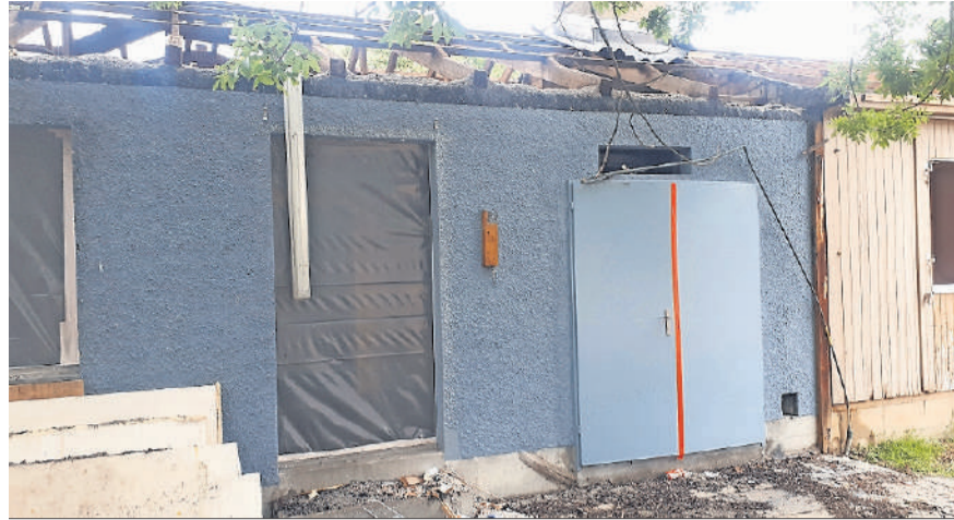
Gift auf dem Juchareal. «Die Bauteile sind abgesperrt (Unterdruckverfahren)», heisst es dazu von AOZ auf Anfrage.
