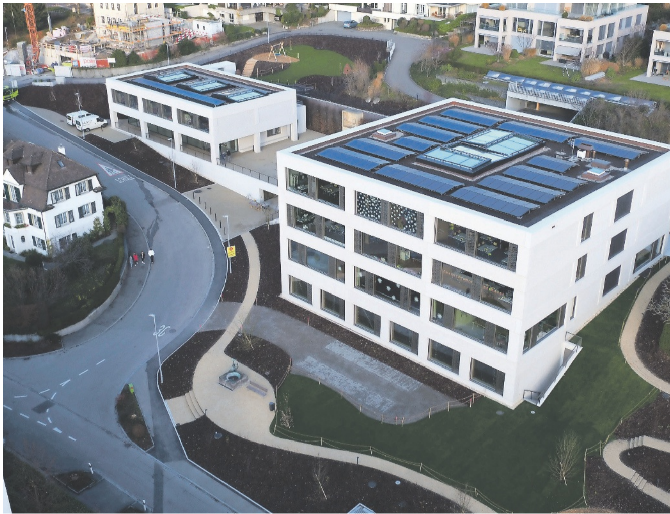
Das ist die Zukunft: Solarzellen nutzen die Sonnenenergie, hier auf dem Dach des Schulhauses Goldbach in Küsnacht.
