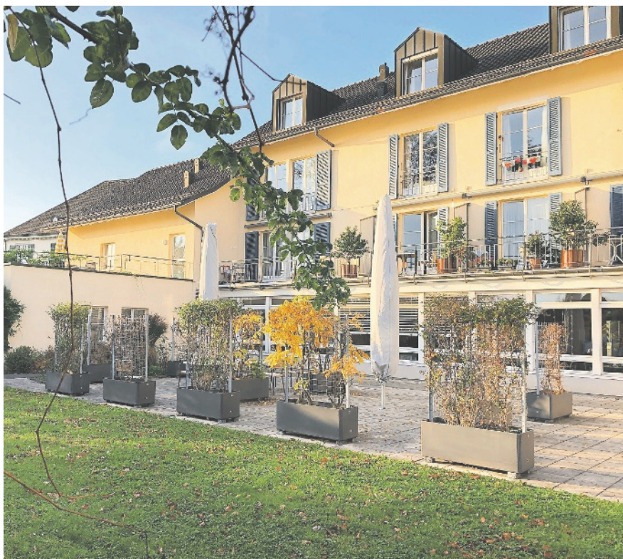
Auf dem Areal Wangensbach sollen 30 der total 80 neuen Alterswohnungen entstehen.
