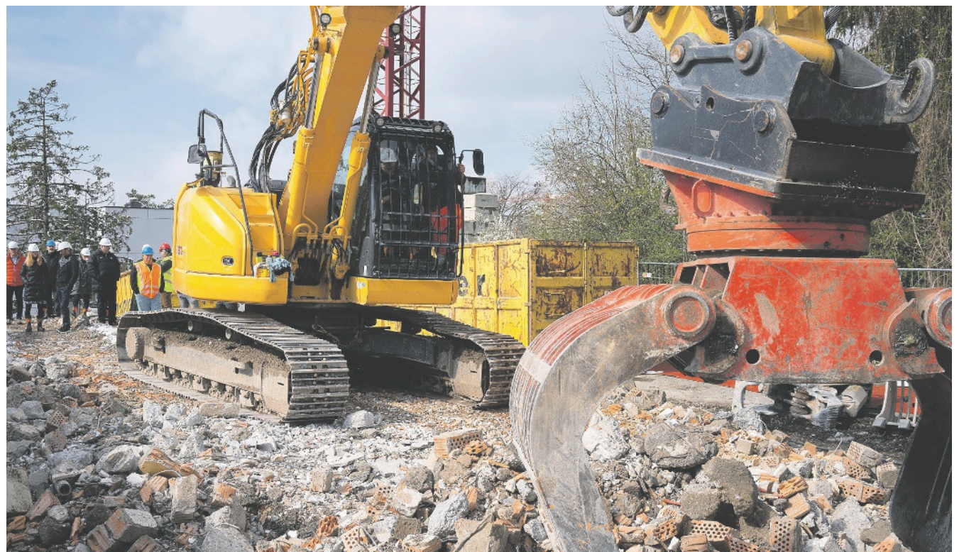
Die Bagger sind aufgeföhren, um die 60-jährige Eisanlage KEK zu renovieren. Die Bauzeit dauert rund elf Monate.
