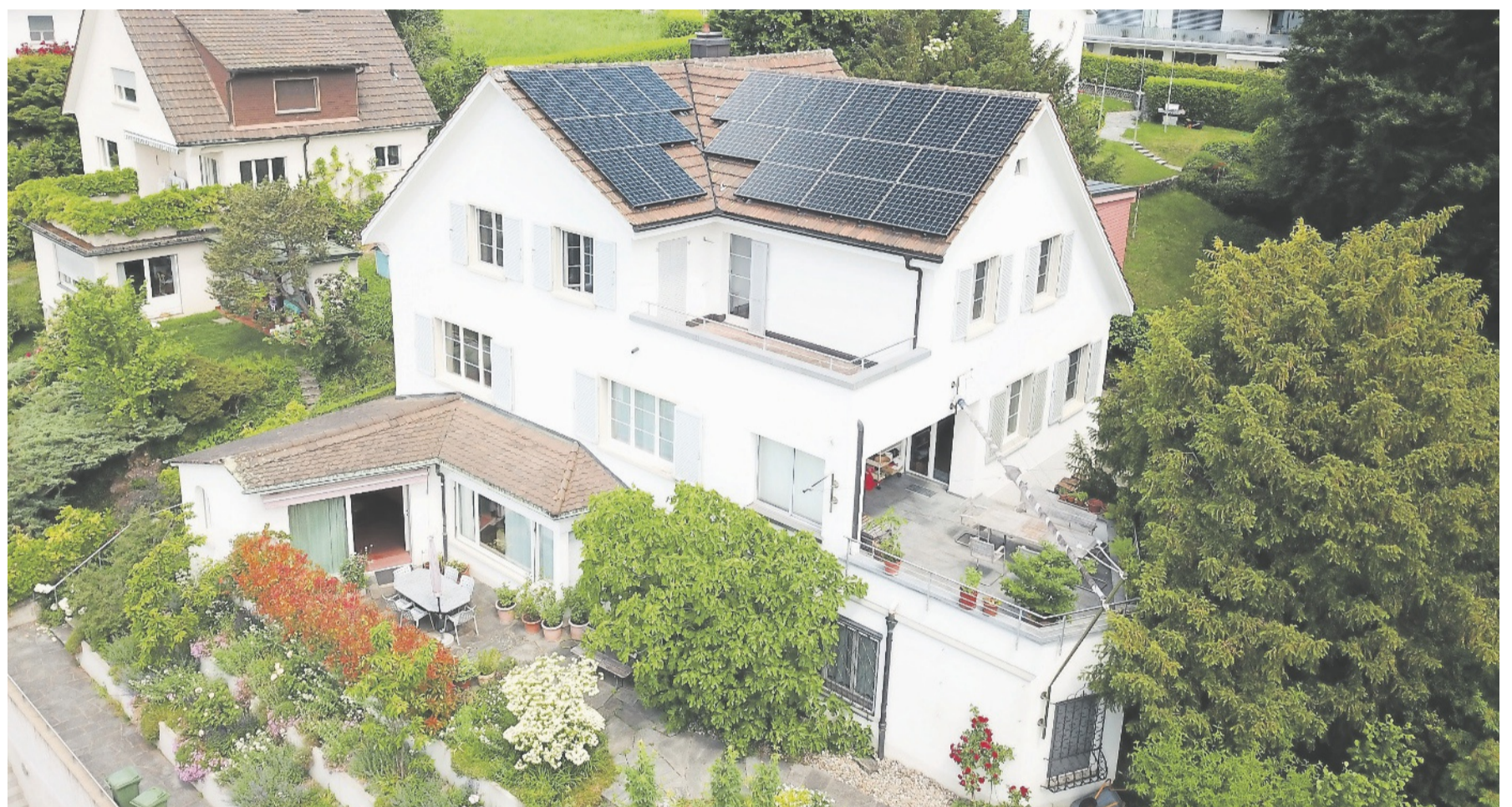
Diese Solaranlage auf einem Küssnachter Privathaus hat mit ihren 22 Modulen eine Leistung von total 8,6 Kilowatt und wird zirka 8700 kWh Strom im Jahr generieren.
