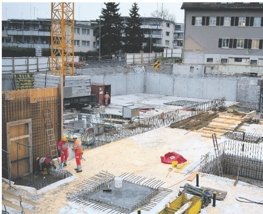
Das neue Feuerwehrgebäude an der Alten Landstrasse nimmt langsam Gestalt an.
