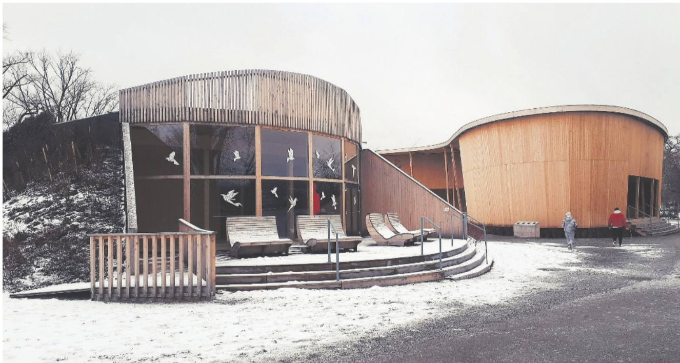
Schon bald Geschichte. All die fertig aufgebauten Pavillons werden wieder abgebrochen.
