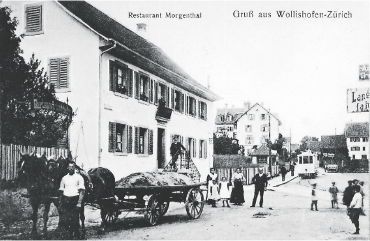
1908 endeten Tramfahrten noch an der Mutschellenstrasse am Morgenthal.
