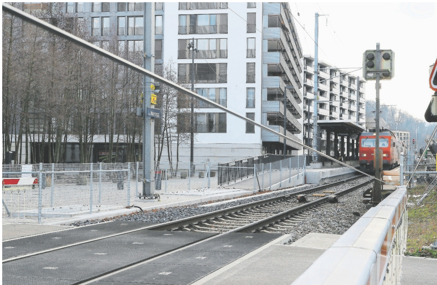
Die Barrieren am Übergang Spindelstrasse schliessen sich für S4-Züge Richtung Stadt schon früh. Bahnnutzende verleitet dies nicht selten zu riskanten Manövern.
