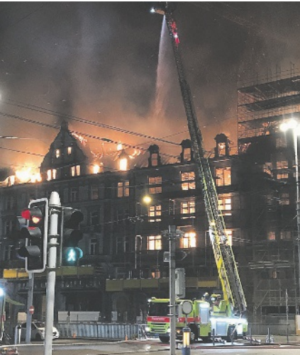
Löscharbeiten beim Grossbrand am Bahnhofplatz im Sommer 2018. BILDER ZVG
