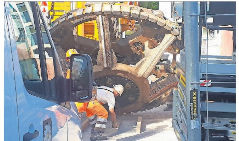
Riesig: Die Bohrköpfe der Tunnelbohrmaschinen. Die Ungetüme wurden per Pneukran aus 29 Metern Tiefe gehoben.
