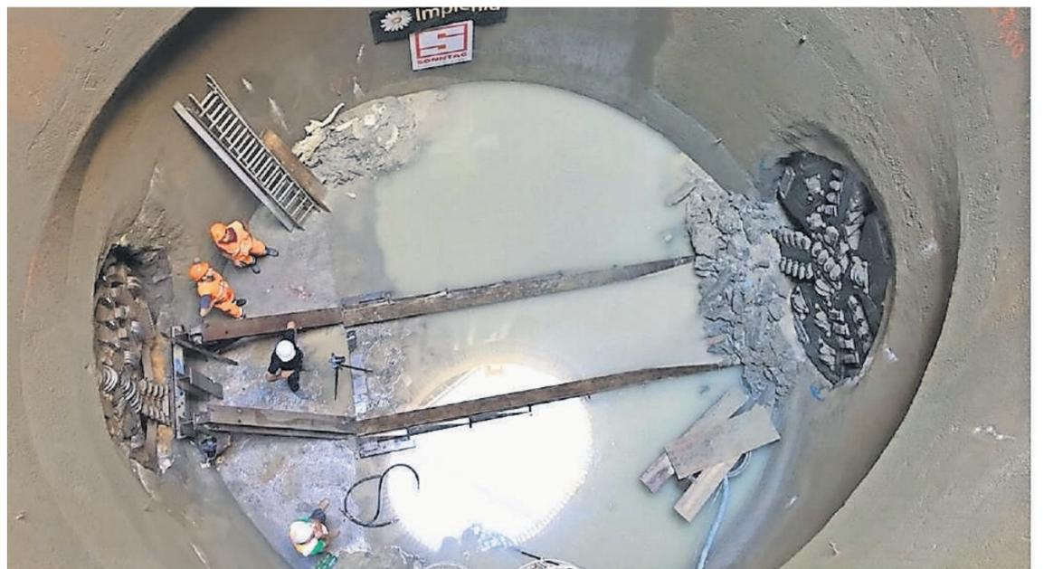
Punktlandung: Die beiden Tunnelbohrmaschinen im Schacht an der Rothstrasse.
