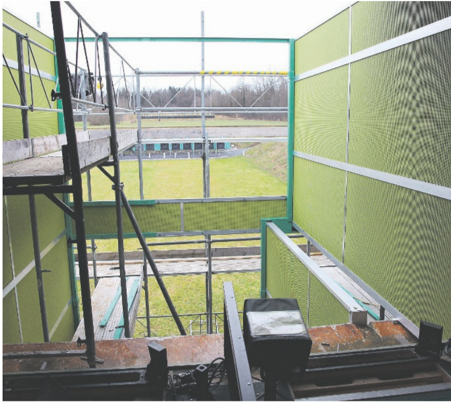
Die Gerüste sind noch nicht abgebaut: In Zukunft wird zwischen Schallwänden geschossen.
