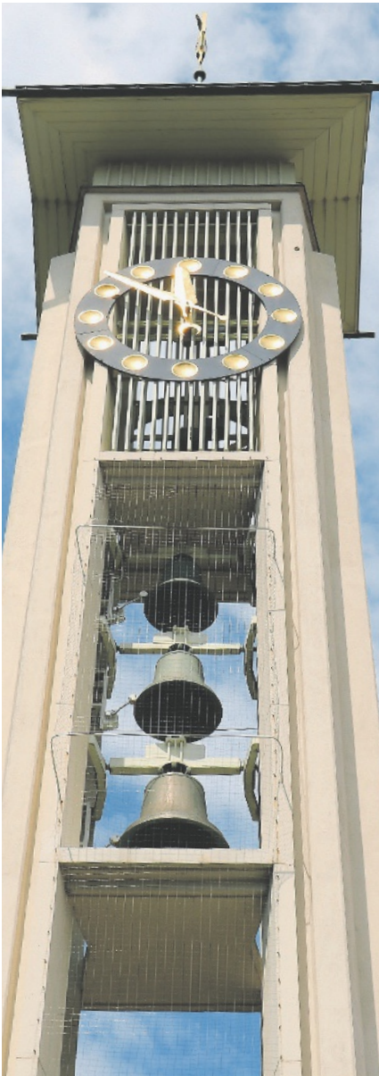
Der frei stehende Kirchturm der Stefanskirche. Dieser soll abgebrochen werden.
