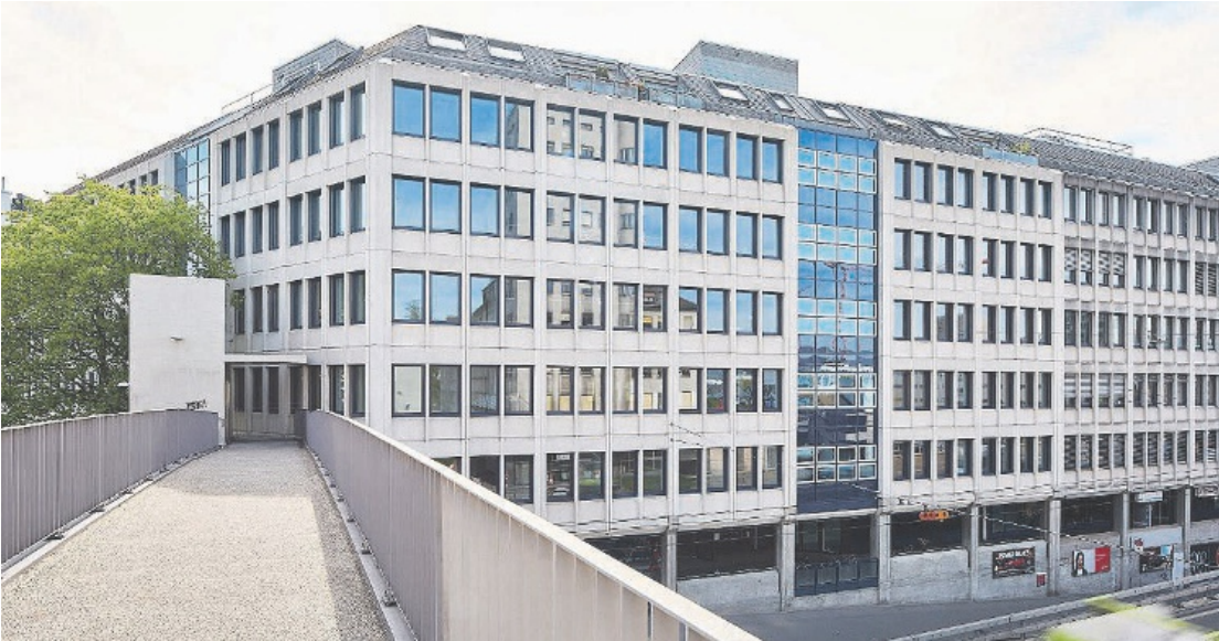
Das neue Sozialzentrum Wipkingerplatz an der Röschibachstrasse 26. Es ist Anlaufstelle für die Quartiere Wipkingen, Höngg, Unterstrass, Oberstrass sowie neu auch Affoltern.
