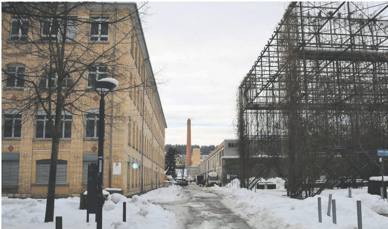
Links ist das historische ABB-Backsteingebäude 87T zu sehen, rechts der MFO-Park und direkt dahinter die Halle 550. Die Industriegebäude in der Mitte mit dem Hochkamin möchte der Quartierverein Oerlikon ebenfalls erhalten.
