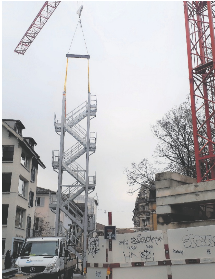
Der Ausbau des Fernwärmenetzes ist laut der Stadt ein «Generationenprojekt». Gebaut wird in mehreren Quartieren, so wie etwa hier in Wipkingen ein tiefer Schacht mit Zugangstreppe. BILD LS
