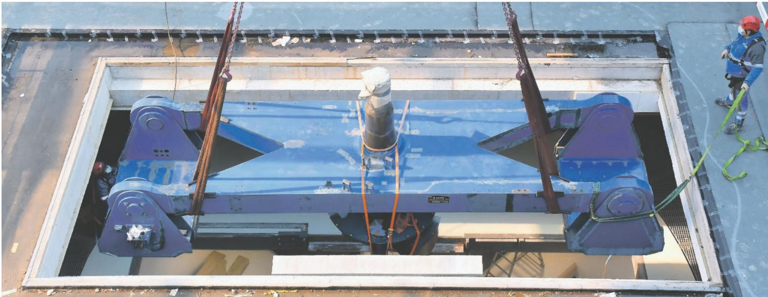
Die geotechnische Zentrifuge der ETH wird langsam in den Untergrund hinabgesenkt. Sie wurde ursprünglich in Bochum verwendet und für die ETH Zürich aufgerüstet.
