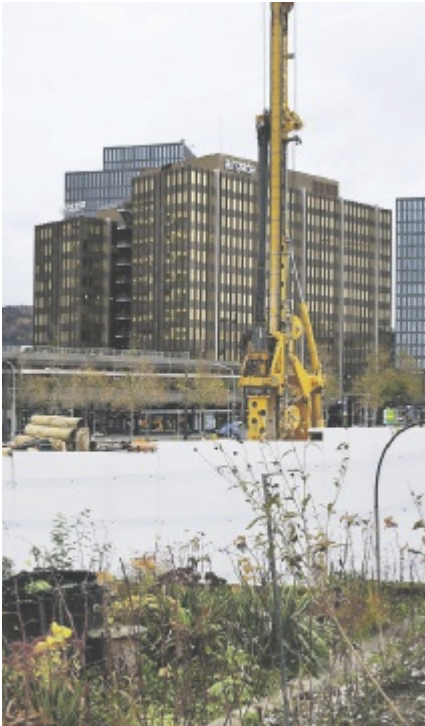
Die Bauarbeiten sind in Gang. BILD PM
