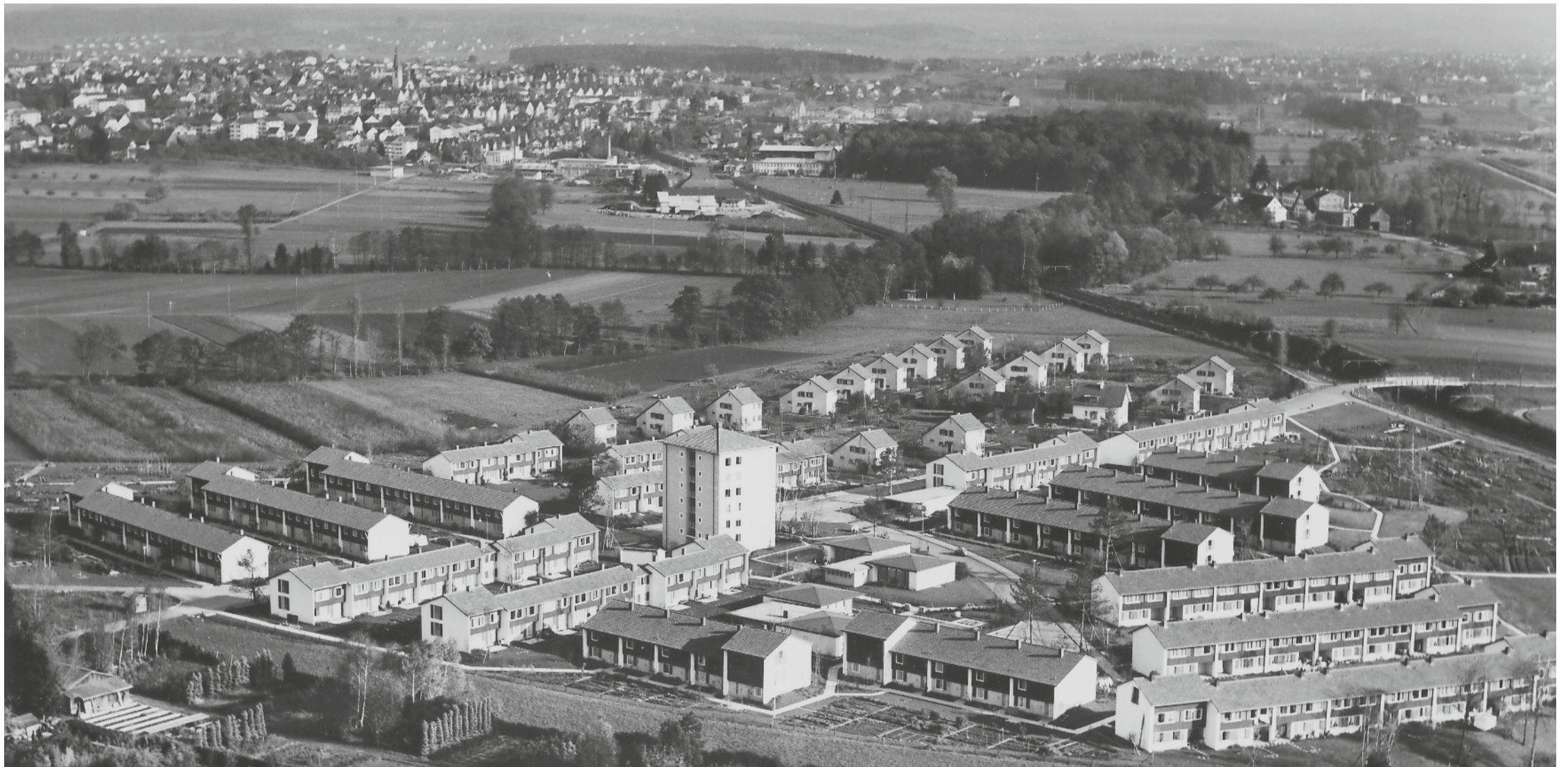
So präsentierte sich die im Zweiten Weltkrieg neu erbaute Wohnsiedlung in den 1950ern aus der Vogelschau. Hinter dem «Hochhaus» die Selbstversorgersiedlung für Arbeitslose. Am Horizont Schwamendingen. BILD ETH BILDARCHIV/BAUGESCH. ARCHIV ZÜRICH
