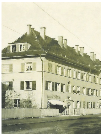
Um diese Überbauung aus dem Jahr 1926 geht es. Sie kann nun nicht wie geplant ersetzt werden. BILD BAUGESCH. ARCHIV ZÜRICH
