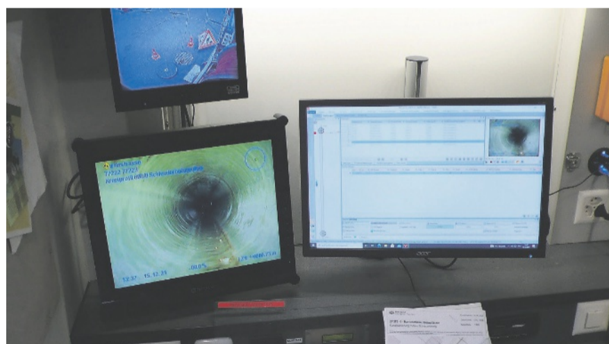
Der Kontrollraum. Hier erfolgt die visuelle Überwachung der gefilmten Röhren.
