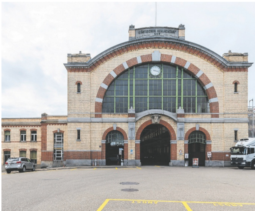
Auf dem Schlachthofareal sind dringende Instandsetzungen notwendig. BILD BAZ/MAURICE K. GRÜNIG
