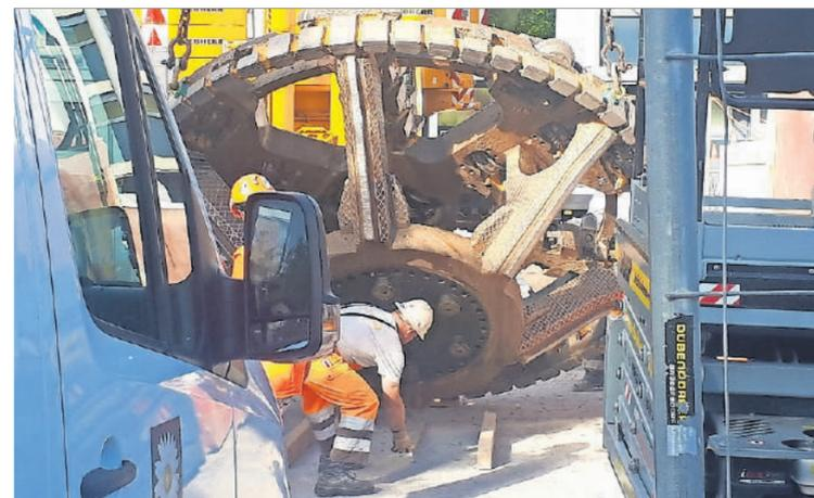
Riesig: Die Bohrköpfe der Tunnelbohrmaschinen. Die Ungetüme wurden per Pneukran aus 29 Metern Tiefe gehoben.
