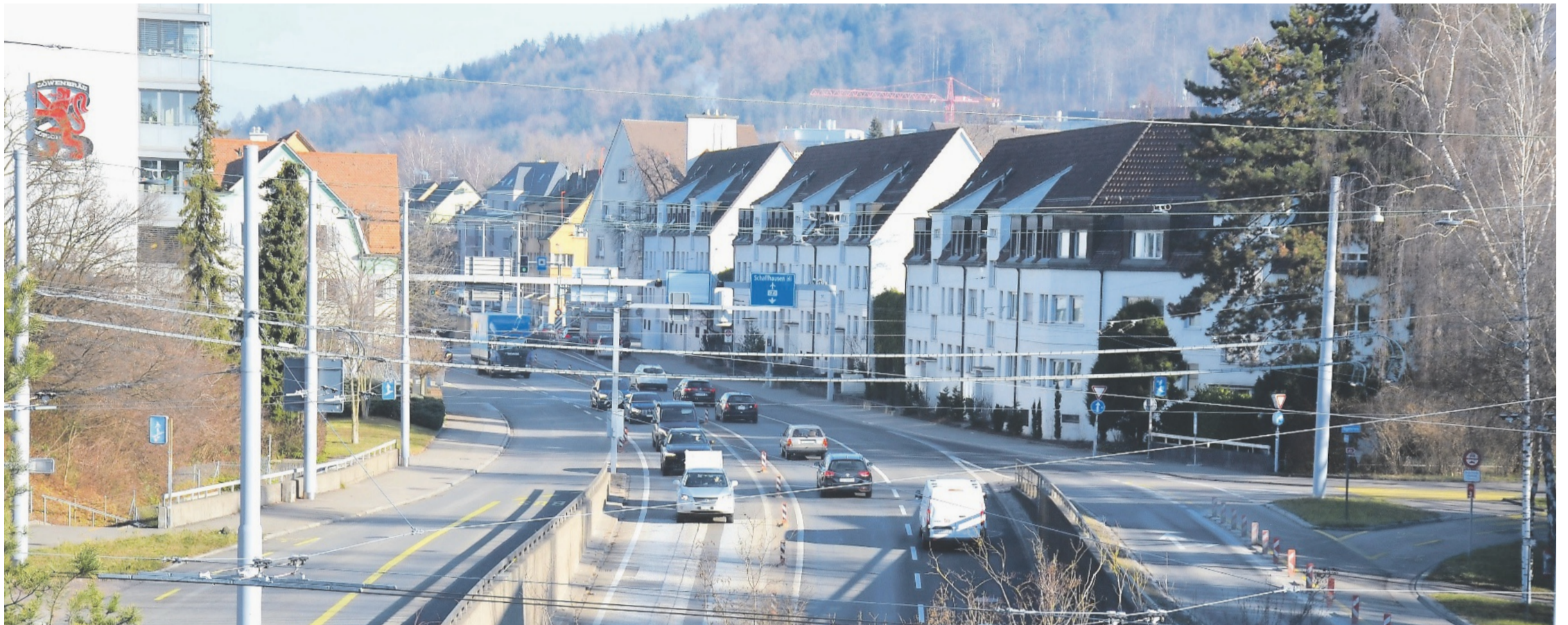
Im Zuge des aktuellen Strassenbau-Grossprojekts Bucheggstrasse wird es bis 2024 rund um die Tunnel Buchegg und Hirschwiesen zu Verkehrsbehinderungen und Umleitungen kommen.
